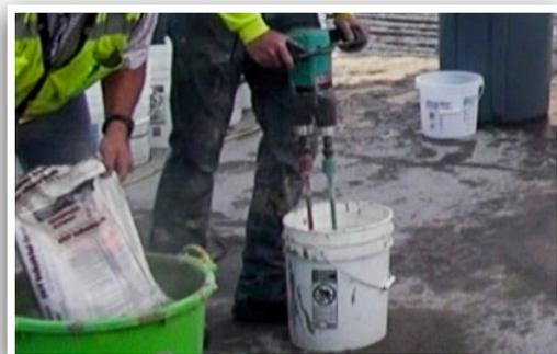
8. Una vez finalizada la mezcla, sumerja inmediatamente las aspas en un cubo de agua y encienda la mezcladora para eliminar todo el exceso de Elephant Armor® de las aspas. El exceso de material que quede en las aspas será extremadamente difícil de eliminar. La limpieza por impacto dañará las aspas.
