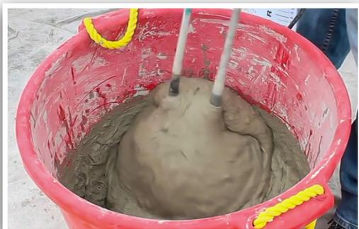
7. Añada el resto del agua y continúe mezclando hasta lograr el espesor deseado. Una vez que Elephant Armor® se haya mezclado completamente hasta alcanzar el espesor deseado, comenzará a fraguar rápidamente. El agua adicional no reemplazará la mezcla.
