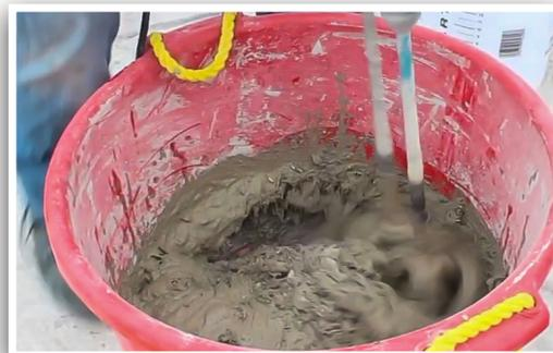
6. Asegúrese de que todo el material ha sido completamente hidratado y mezclado. Esto asegurará una mezcla homogénea proporcionando el máximo rendimiento del Elephant Armor®.
