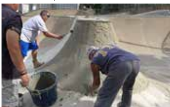
Elephant Armor® aplicado con llana y rodillo GST, sin necesidad de cimbrar.
