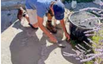
Elephant Armor® DOT se utiliza para rellenar todos los desprendimientos y grietas profundas.
