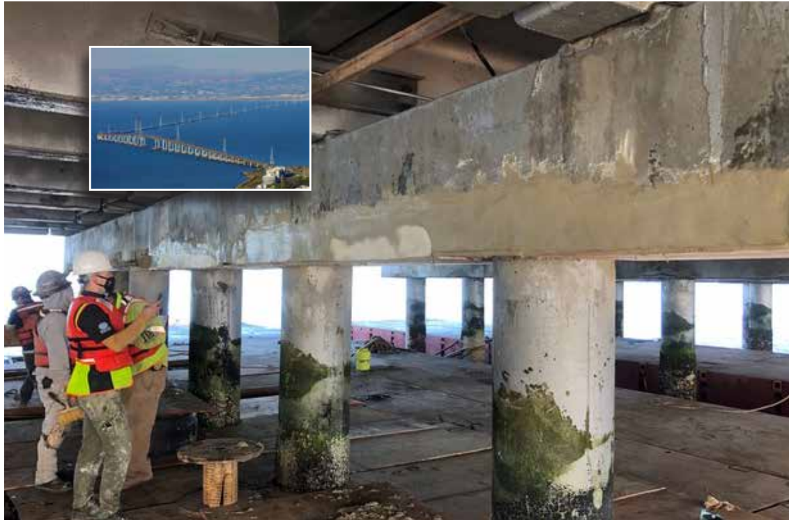
Concreto dañado y en mal estado removido y preparado para la aplicación de Elephant Armor®.
