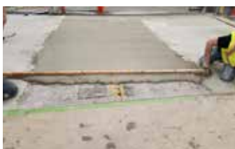
El panel central está relleno con Elephant Armor® hasta el nivel de los dos paneles exteriores.
