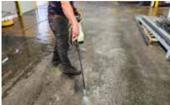
Limpiar el suelo con Pro-Grade Cleaner antes de aplicar Ecobeton® Vetrofluid.
