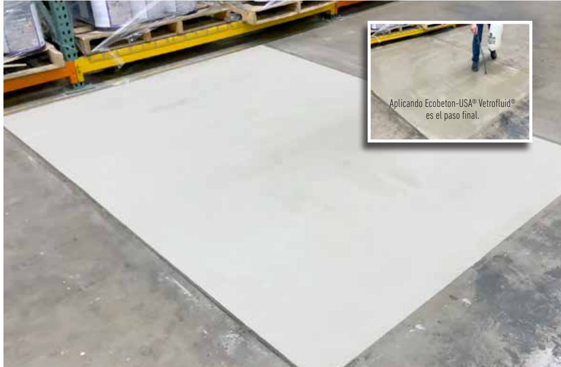
El panel del piso de la bodega volvió a tener una apariencia 'nueva' y está lista para el tráfico pesado de montacargas. Se hizo un acabado con una escoba para reducir el riesgo de 'resbalones y caídas'.
